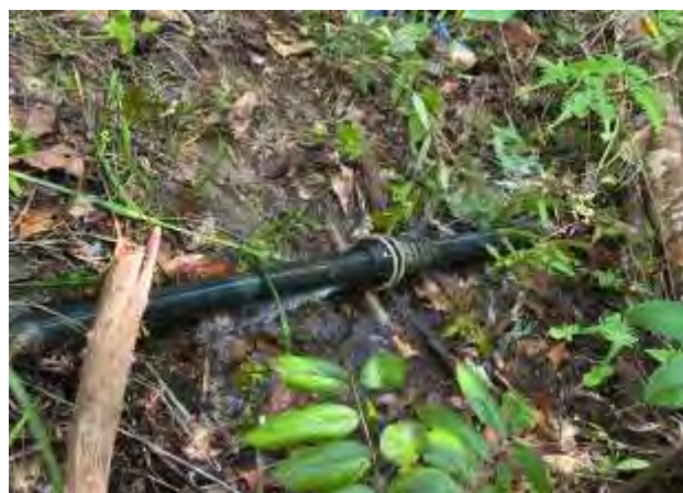
事業開始前の劣化し、漏水する導水パイプの様子
