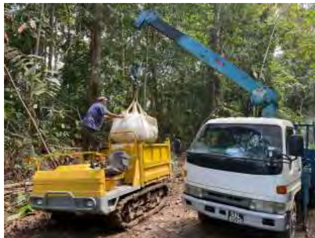
左：作業道整備、右：堰堤造成用資材搬入
