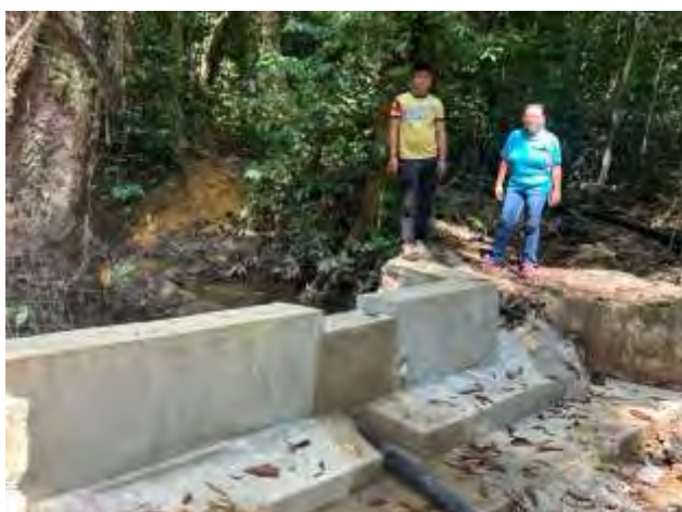
左：堰堤が完成、右：導水パイプを接続
