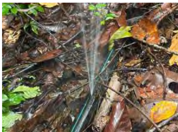
事業開始前の劣化し、漏水する導水パイプの様子
