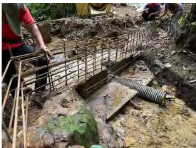
左：配筋作業、右：コンクリート打設
